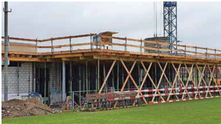
Das Sporthaus im Rohbau. Gemäss Zeitplan sollen noch in diesem Jahr Fenster und Aussentüren eingebaut werden. Bild: Peter Marti
