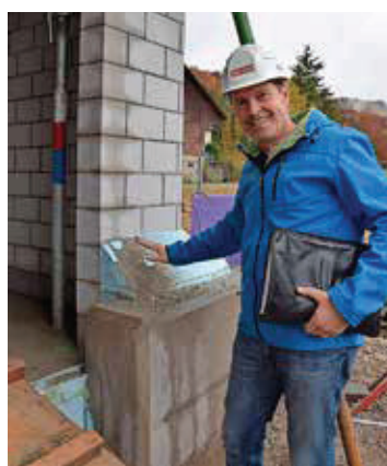
Über dem Betonsockel werden noch die Klinker angebracht.
